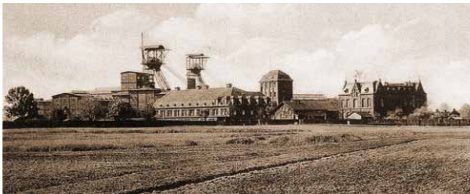
Budynek cechowni dawnej KWK „Gliwice” przy ul. Bojkowskiej 37, fot. Ewa Pokorska-Ożóg.
