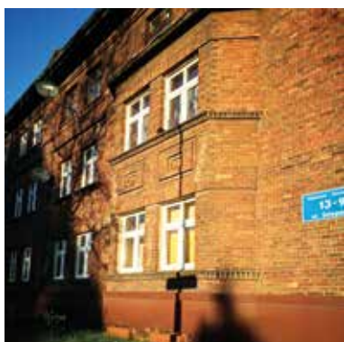
Widok fragmentu elewacji frontowej bloku mieszkalnego przy ul. Sztygarskiej 9-11, fot. Ewa Pokorska-Ożóg.
