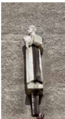
Rzeźby znajdujące się nad wejściem do kościoła, przed pracami konserwatorskimi, fot. Ewa Pokorska-Ożóg.
