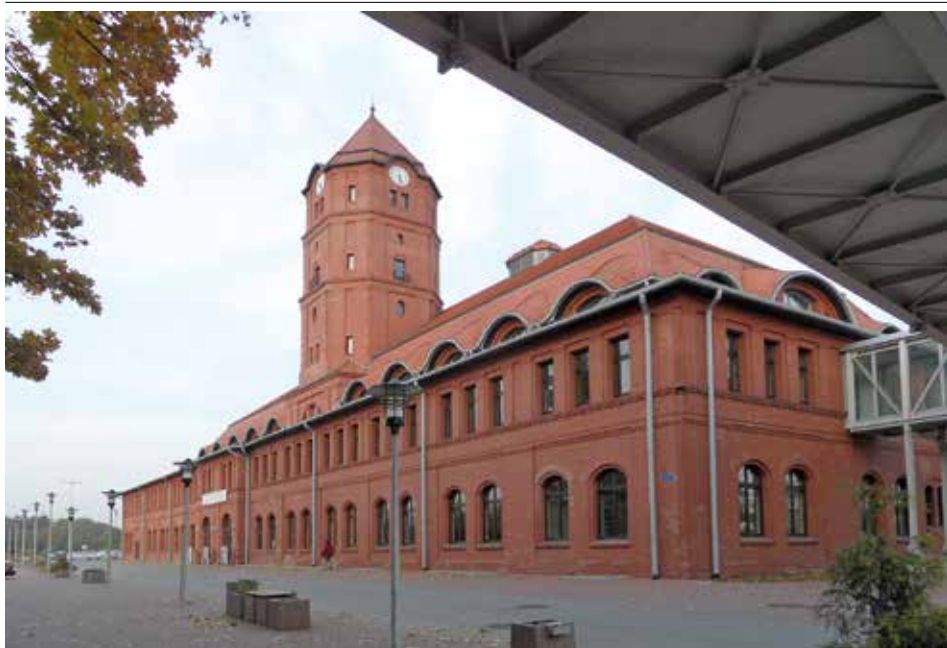
Budynek cechowni dawnej KWK „Gliwice” przy ul. Bojkowskiej 37, fot. Ewa Pokorska-Ożóg.
