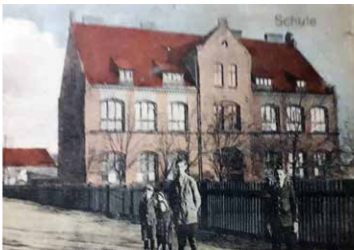
Budynek SP 21 (dawnej SP 14b). Zdjęcie z lat 30 XX w., fot. archiwum.
