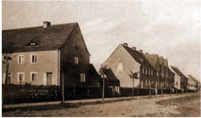
Widok osiedla celników w Sośnicy z około 1929 roku, fot. arch. prywatne.
