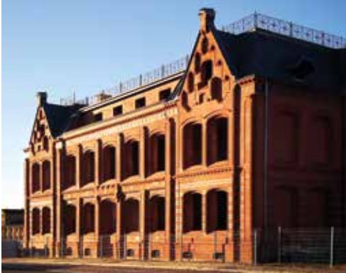
Fasada z interesującym elementem znajdującym się w 5 osi parteru w formie krenelaza wieńczącego okno, dawniej w tym miejscu znajdowało się wejście do budowli, fot. Ewa Pokorska-Ożóg.
