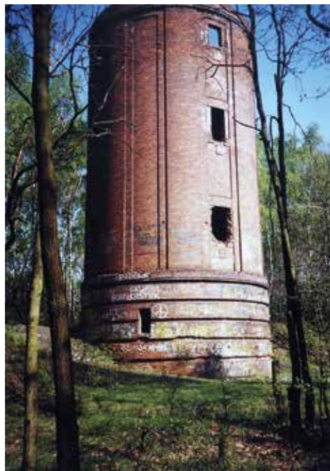
Pozostałości wieży ciśnieniowej w lasku sońnickim.
