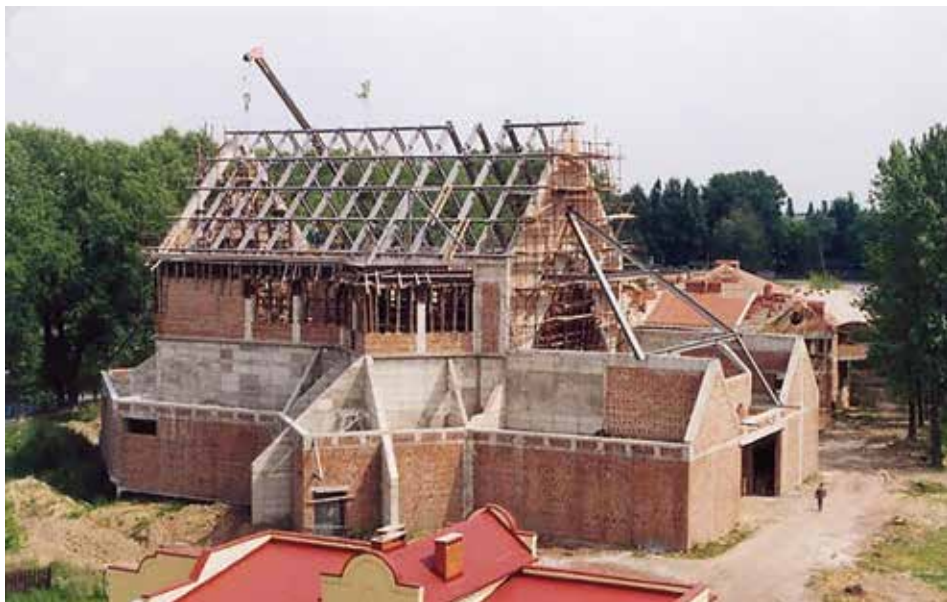
Stan budowy kościoła św. Jacka 3.6.2000, fot. Karol Kasprowiak.
