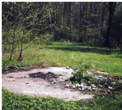
Płyta żelbetowa przykrywająca zasypany szyb Leśny kopalni „Makoszowy”.
