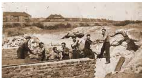
Budowa sztolni w 1950 r. przy ul. Sikorskiego, za starą szkołą górniczą, fot. arch. prywatne.
